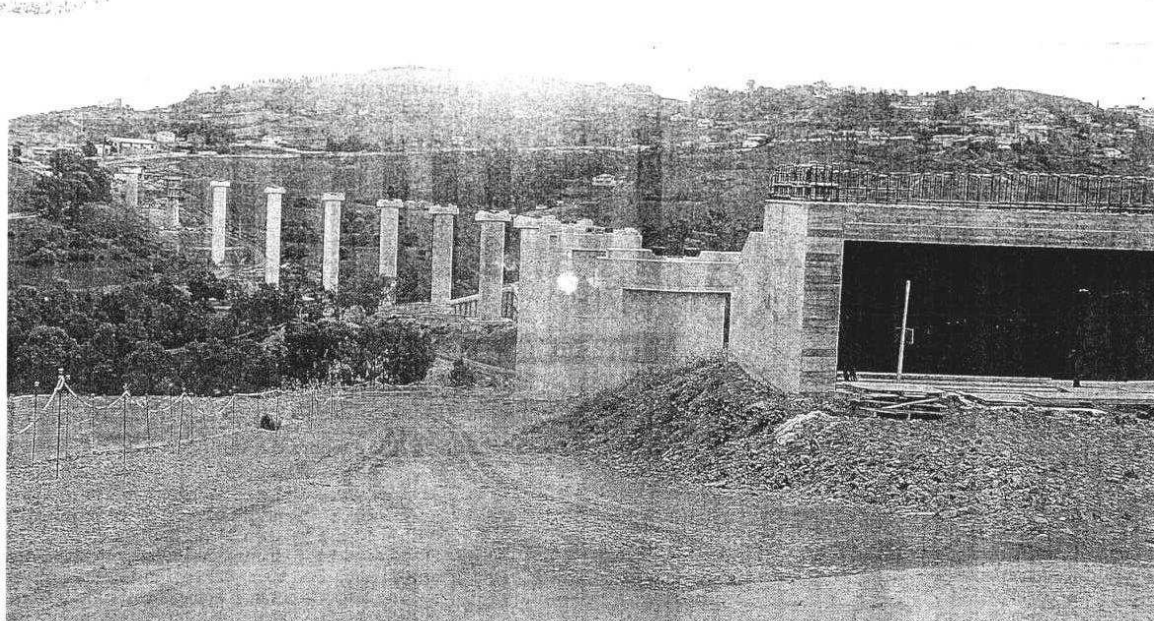
I LAVORI INTERROTTI SULLA LIBERTINIA-LICODIA EUBEA
